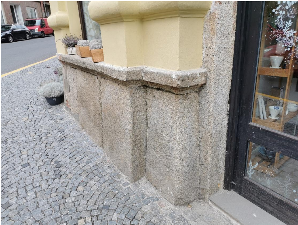
Detail kamenného soklu před obnovou
