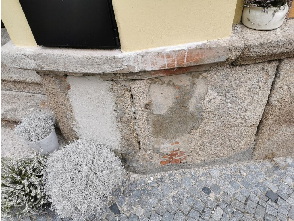
Detail kamenného soklu před obnovou
