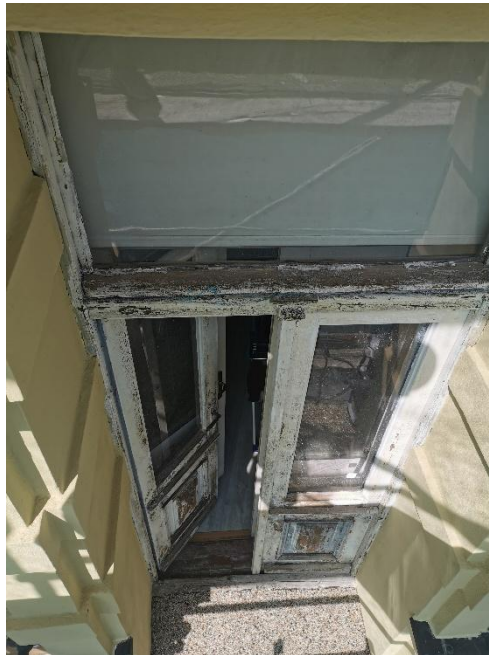
Balkonové dveře před obnovou
