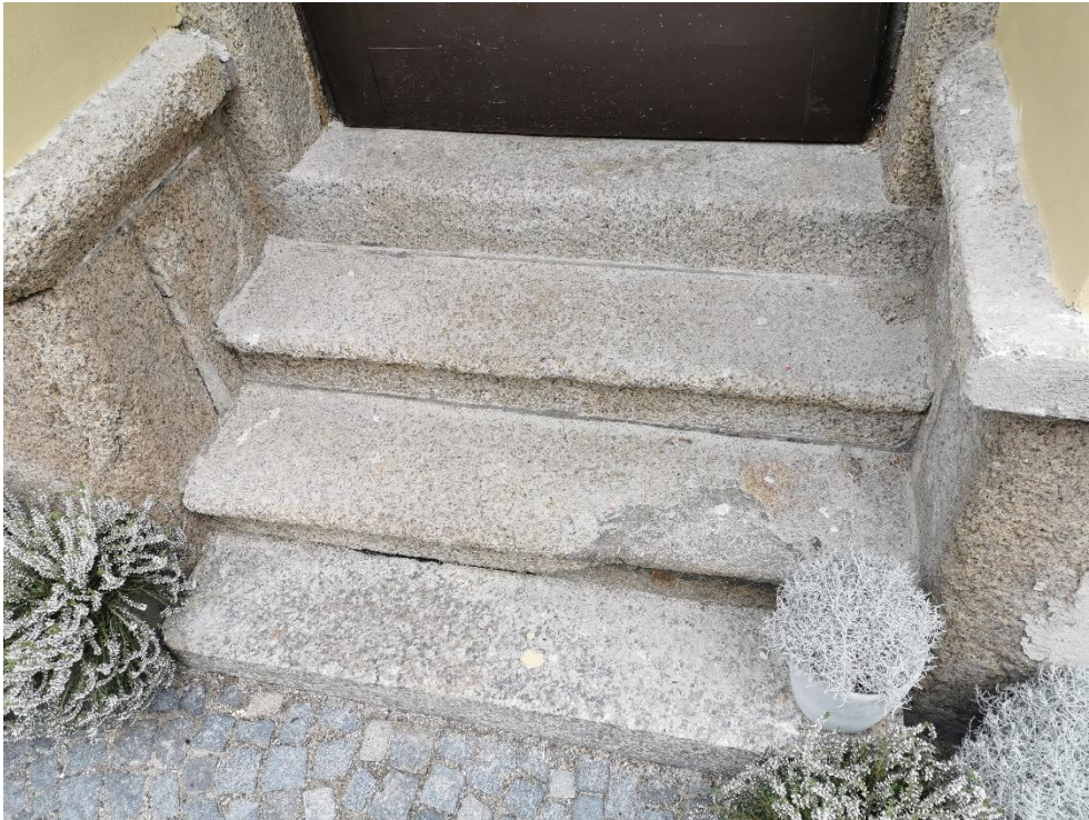
Detail kamenného schodiště před obnovou
