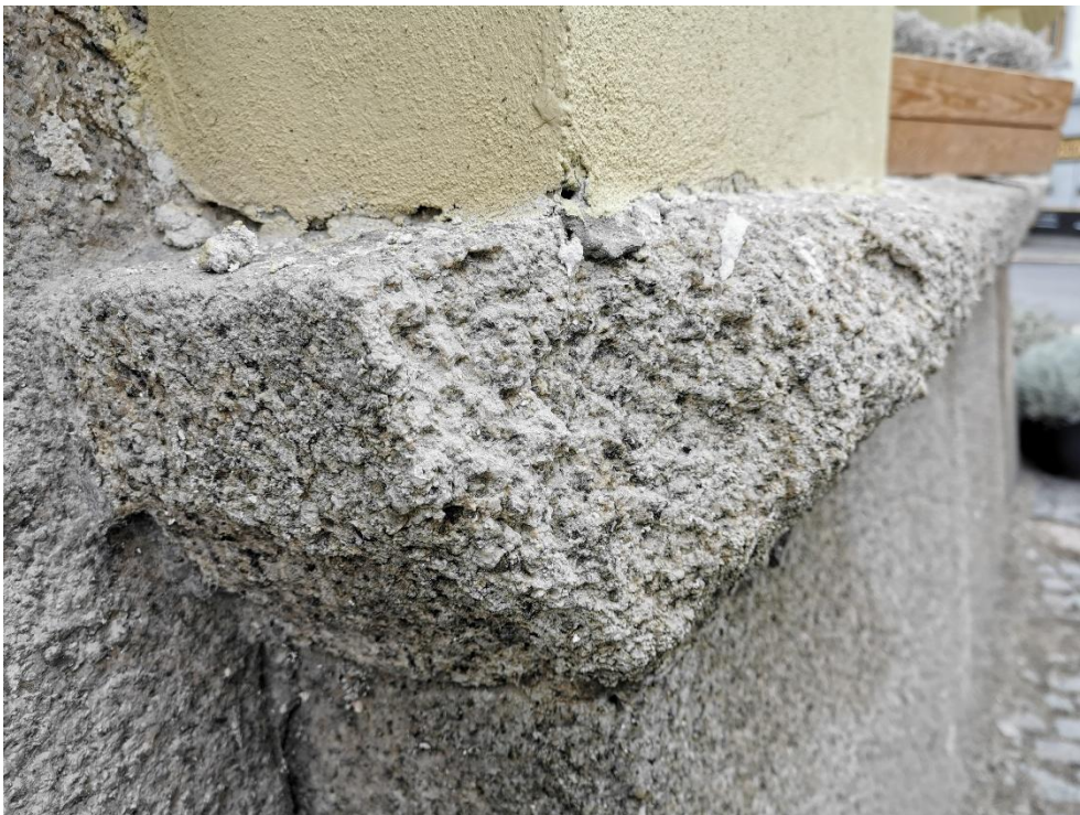
Detail kamenného soklu před obnovou
