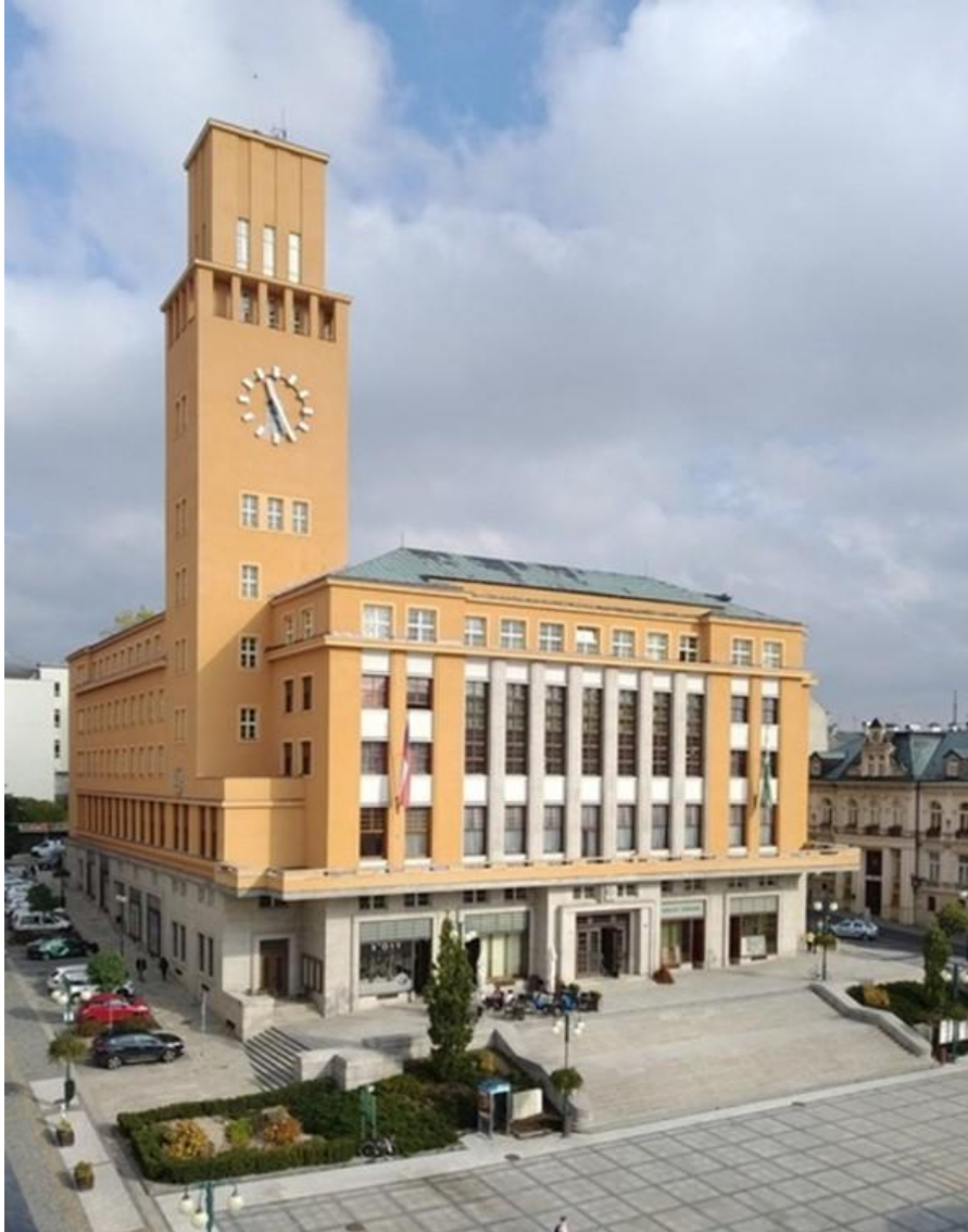
Celkový pohled na objekt
