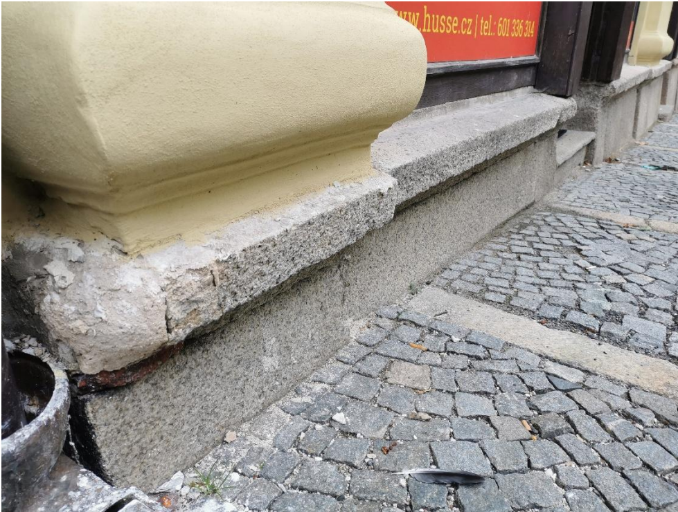
Detail kamenného soklu před obnovou
